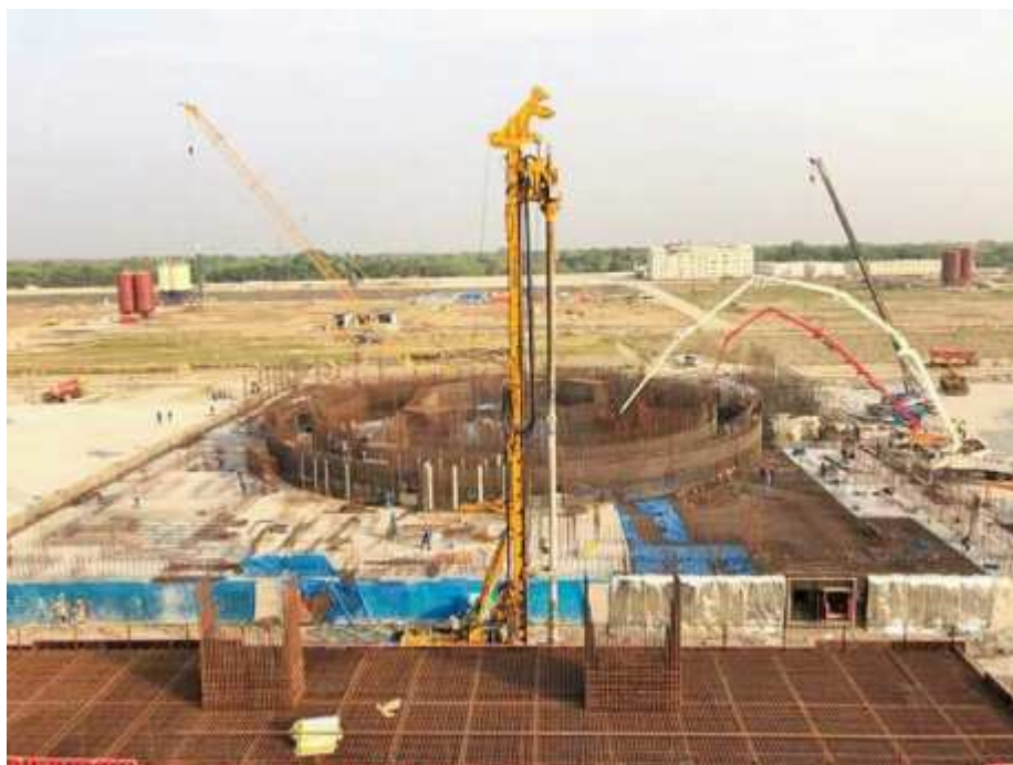
Betonování základové desky JE Rooppur 1 (Image: Rosatom)
