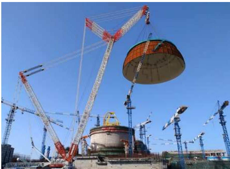
Osazování kupole vrchlíku kontejnmentu
