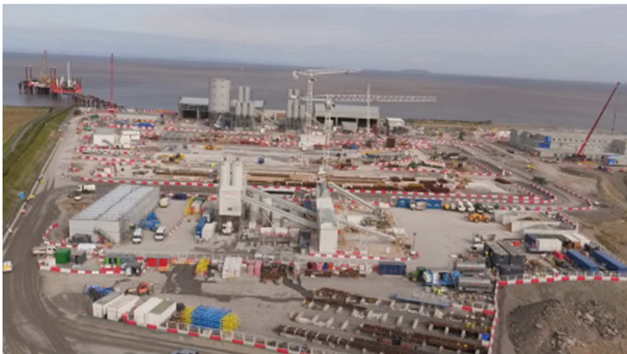
Příprava staveniště Hinkley Point C
